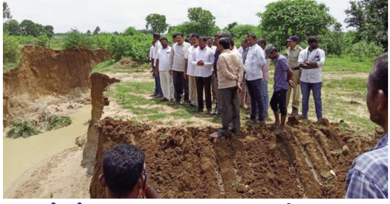
34 కోట్లతో వెంగళరావు ప్రాజెక్టు అలగు నిర్మాణానికి ప్రతిపాదనలు 10 లక్షల రూపాయలతో గండికి తాత్కాలిక మరమ్మత్తులు వచ్చే వర్షాకాలం నాటికి పూర్తి స్థాయిలో అలగునిర్మాణం
